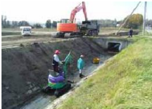
水路の土砂上げ
