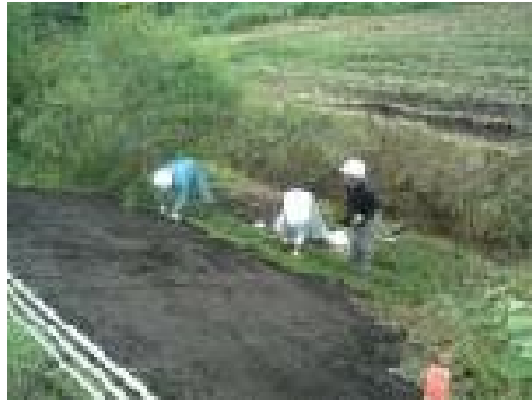
農道法面の補修
